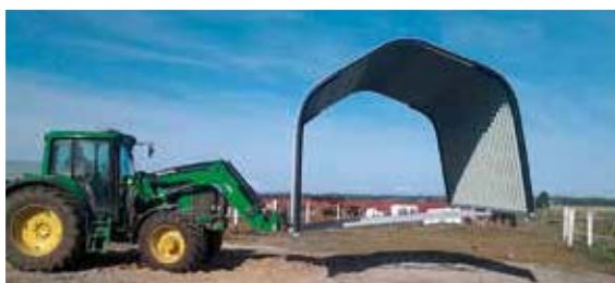
Dzīvnieku nojumes pārvietošanu var viegli veikt ar traktoru, kas aprīkots ar iekrāvēja dakšām.
